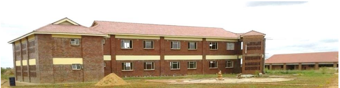
April 2020 – rechts im Bild das fast fertige Verwaltungsgebäude
