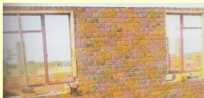
Baufortschritt Sekundarschule im Oktober 2018
