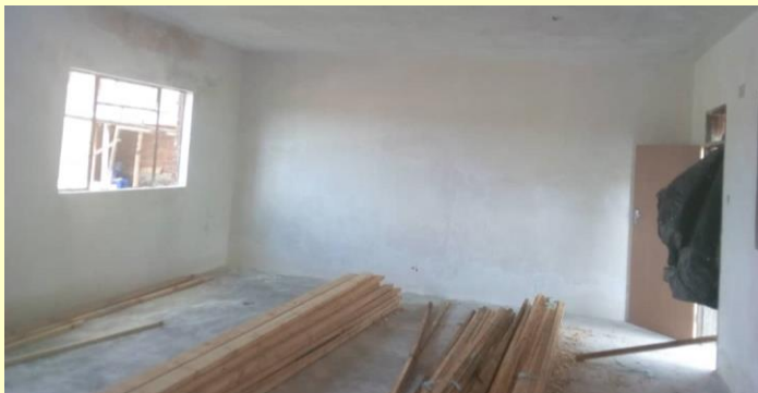
Blick in einen Klassenraum – Februar 2019
