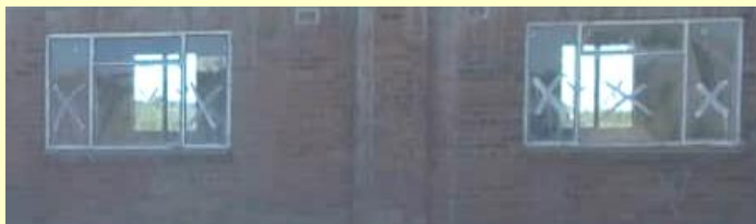
Die verglasten Fenster des Neubaus – April 2019
