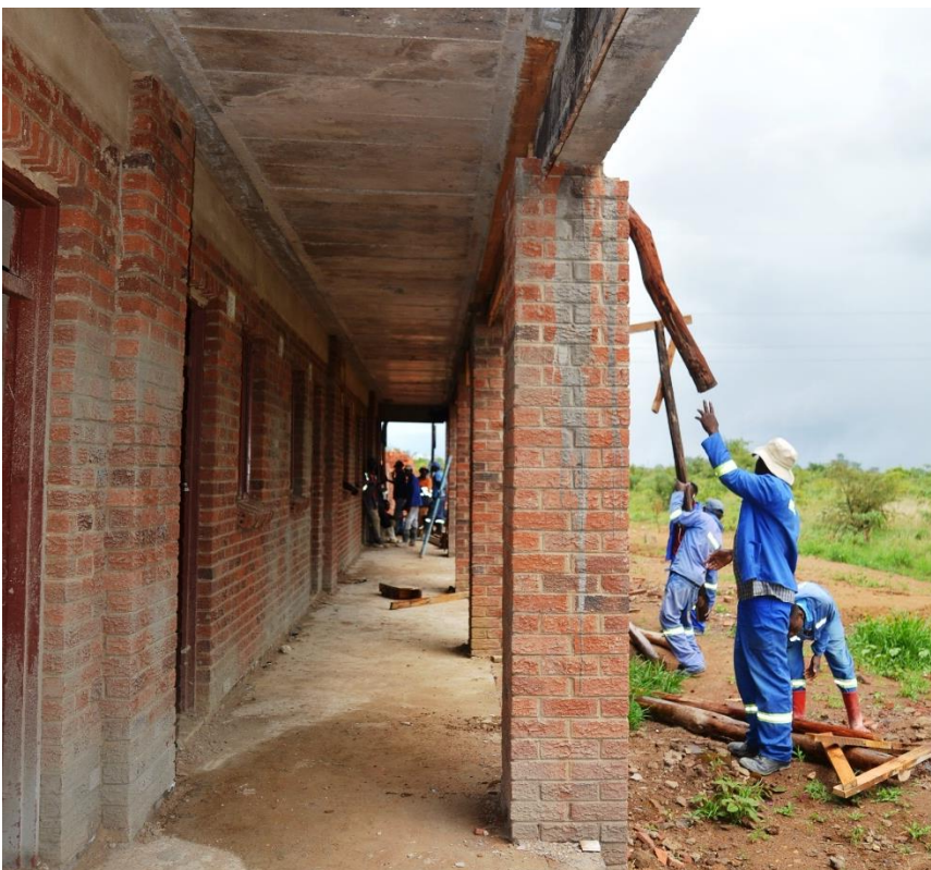
Inzwischen sind die Mauern hochgezogen, das Dach ist/wird gedeckt über der 2. Etage. Die Fertigstellung des Gesamtbaus benötigt aber noch viel Zeit, geplante offizielle Eröffnung: Jan. 2020.
