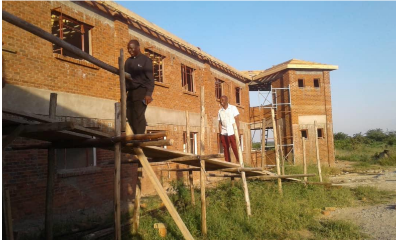
Die Dachdecker sind da ...
