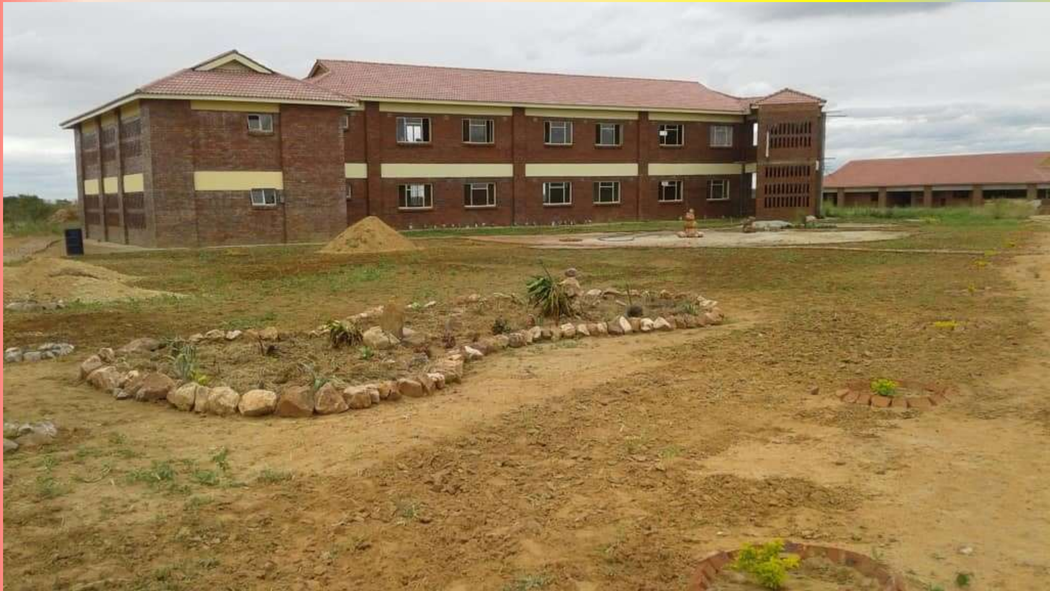
1. Bauabschnitt Mary Ward High School – rechts hinten Verwaltungsbau für alle 3 Bauabschnitte
