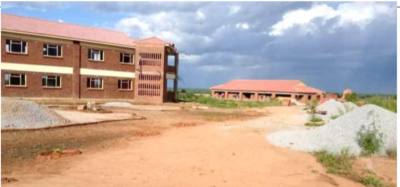
High School (li) und Verwaltungsgebäude (re)
