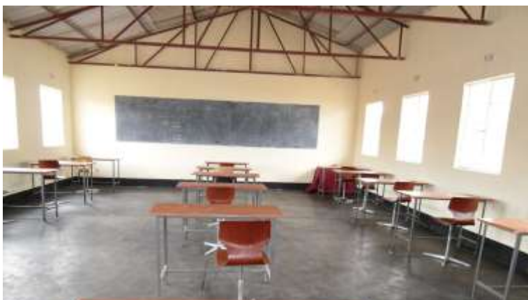
Anbau eines Schulraumes mit zusätzlicher Hilfe der Mainzer Schule
